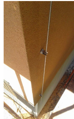
Blitzschutzanlage
